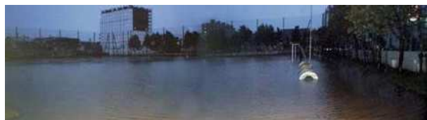
（事例）校庭を活用した流域貯留施設
