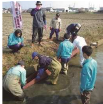
④集落総出で魚道を設置
