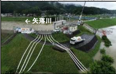
排水作業で堤防天端を使用すると復旧活動で堤防上を往来できない
