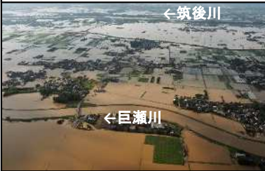
堤防沿いに高台が無いと氾濫時の円滑な復旧活動は困難
