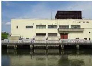
中川流域における浸水被害軽減のため、大場川の洪水を江戸川に排水するための大場川下流排水機場の増強を実施。
