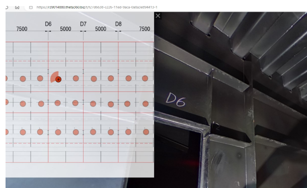
図-4 360°カメラを使用した箱桁内写真
