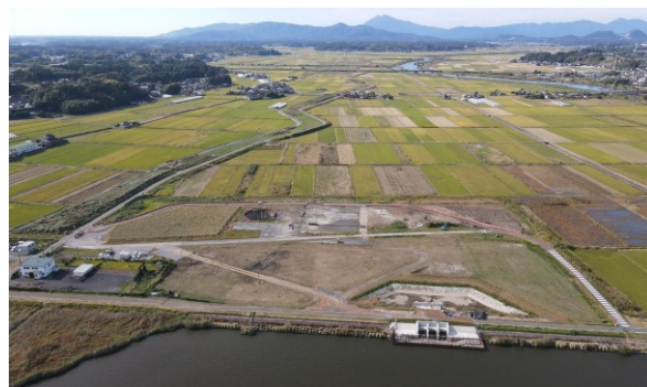
写真－1 第2機場（高浜機場）建設予定地
