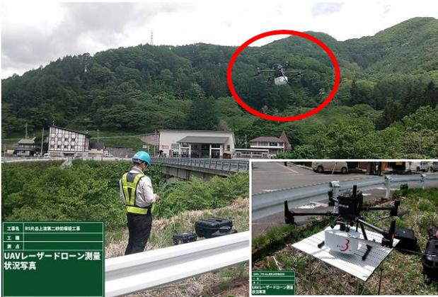
図-2 データ取得のためのドローン作業風景
