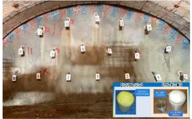
写真-2 長尺鋼管フォアパイリング完了状況
