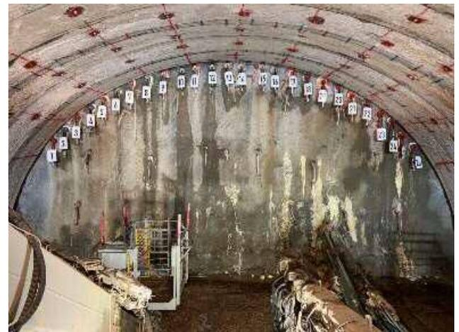
水抜きボーリングによる地下水低下対策
