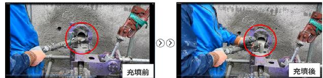
写真-5 鉄筋挿入工のグラウト材充填確認への活用例
