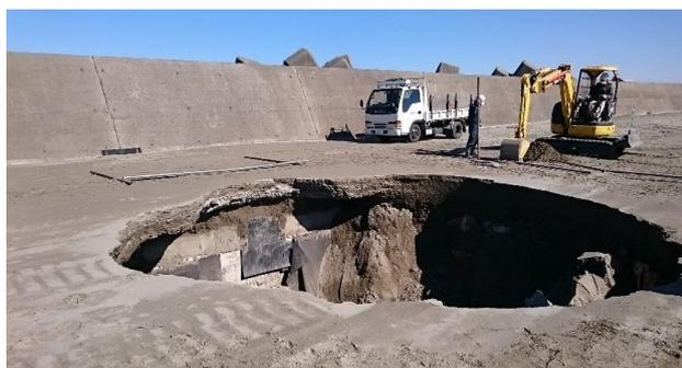
写真-1 ケーソン護岸における陥没の発生状況<sup>1)</sup>
