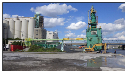
写真3：日の出胸壁（岸壁側）
