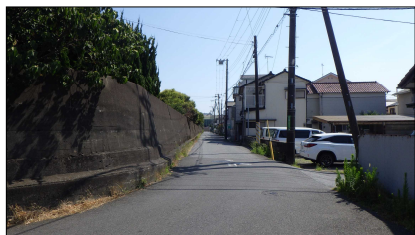
写真1：湊護岸（背後側）
