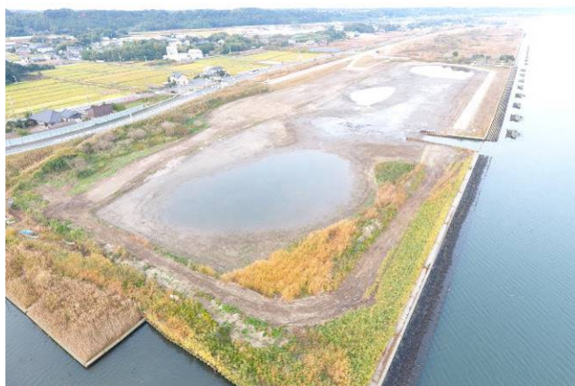
図4 自然再生工事完了後の船木・椎柴地区
