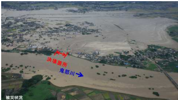
写真-1 茨城県常総市三坂地先（鬼怒川決壊箇所）
