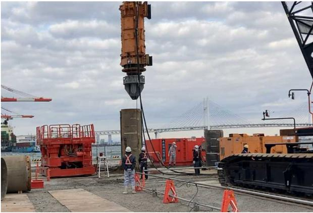
写真-1 先行削孔砂置換併用打撃工法の施工状況
