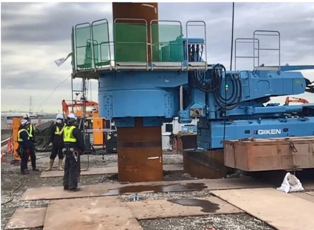
写真-2 回転切削圧入工法の施工状況
