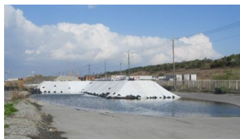
写真-2 土砂仮置き状況
