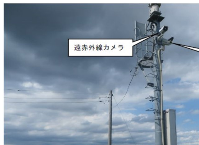
写真5 機器設置状況(新鎗川橋)
