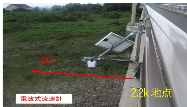
写真4 電波式流速計設置状況(新鎗川橋)
