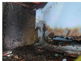
図-3 【主桁】腐食C 2 判定の要因
