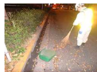
写真-5 人力による清掃
