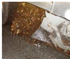
写真-2 落ち葉の堆積状況
