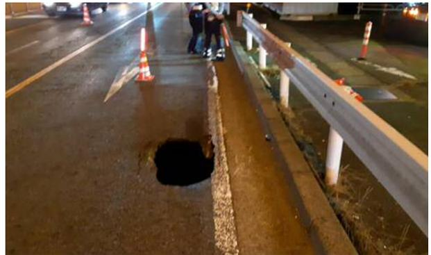
図-1 路面陥没の発生状況
