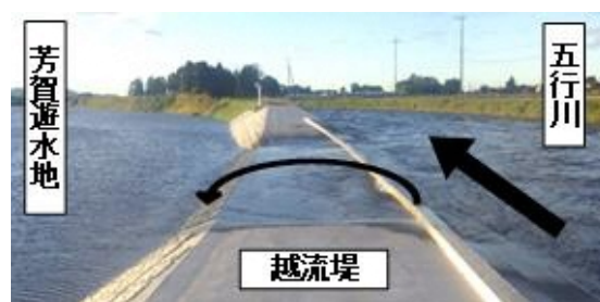
写真-4 令和元年東日本台風接近時の越流状況
