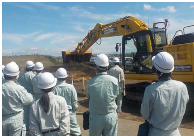
写真-2 ICT活用工事の現場見学会の様子
