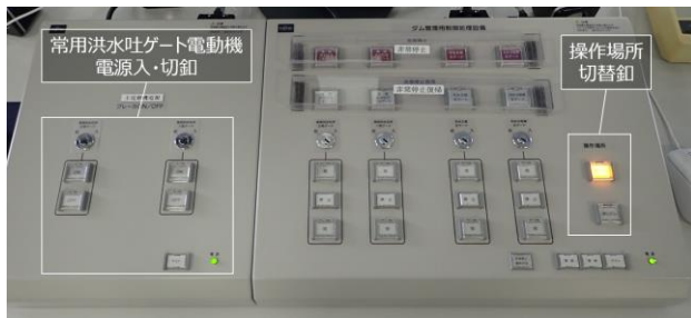
写真-3 ダムコン更新後の操作卓外観(総管)
