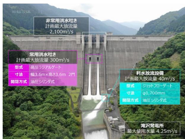
写真-1 滝沢ダム放流設備の構成
