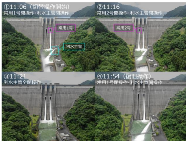
写真-4 遠隔操作試行状況
