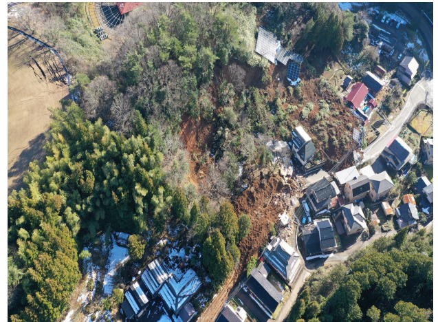
図-5 斜面崩落状況【石川県穴水町川島町】
