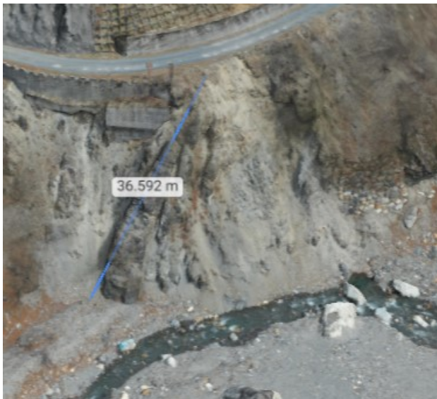
図-4 作成した三次元データ 【釜無川工事用道路 5.6km 付近】
