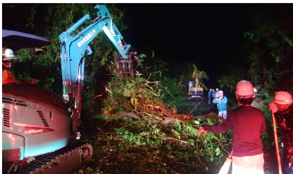
写真-3 倒木撤去作業中
