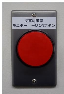
図7 大型モニタ起動システム
