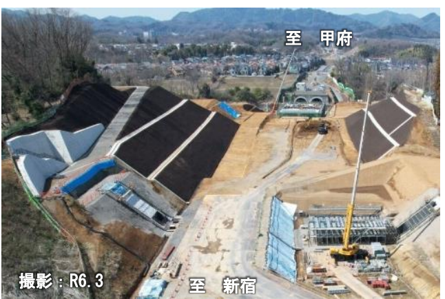
写真② 寺田地区改良工 状況
