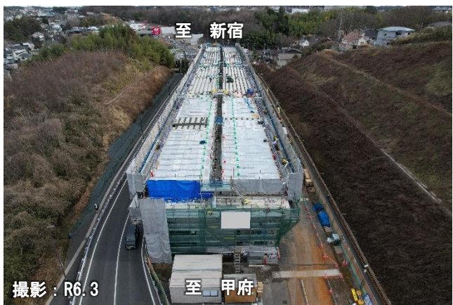
写真③ 大船寺田高架橋 状況
