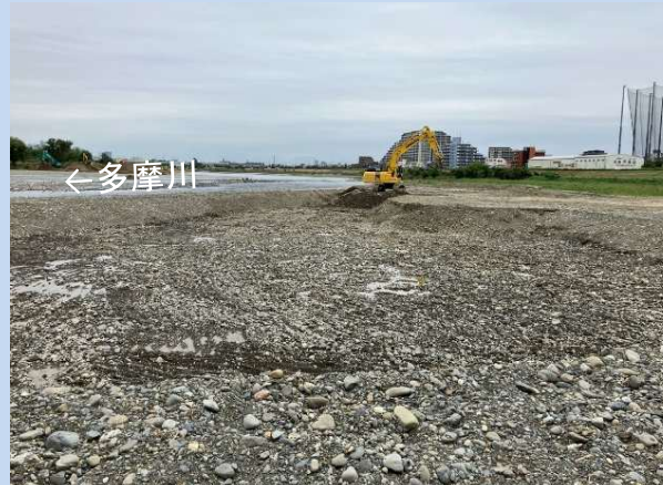
河道を掘削しています。 (令和6年10月)
