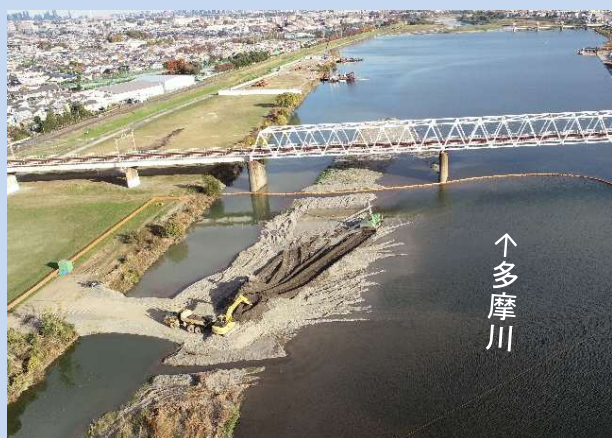
河道を掘削しています。 (令和6年11月)
