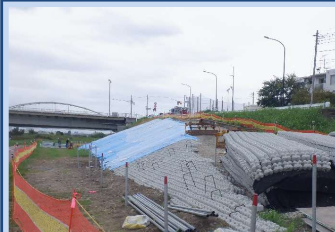
工事用道路を整備しています。 (令和6年9月)
