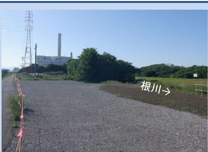
工事着手前 (令和6年6月)
