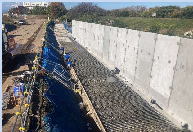
擁壁を設置しています。 (令和6年11月)
