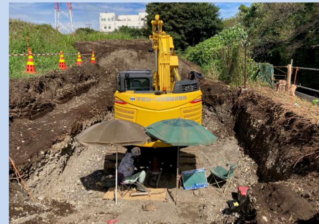
地盤の強度を確認しています。 (令和6年8月)
