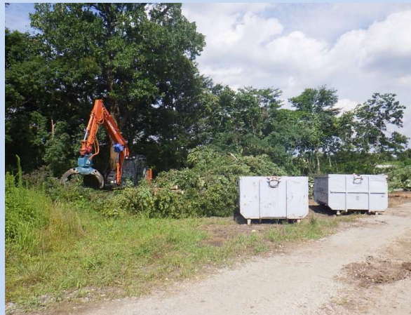
樹木を伐採しています。 (令和6年7月)
