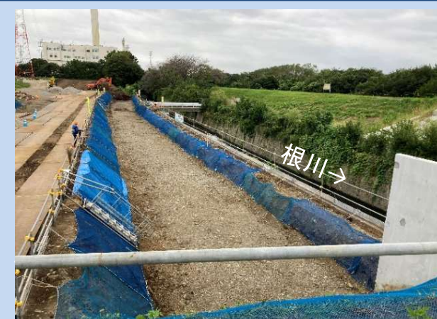
擁壁を設置するための床掘りが完了 しました。(令和6年9月)
