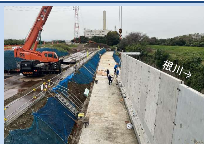
擁壁を設置しています。 (令和6年10月)
