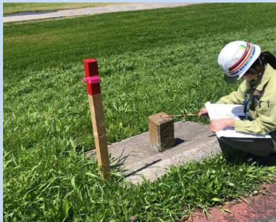
工事に入る準備をしています。 (令和6年5月)
