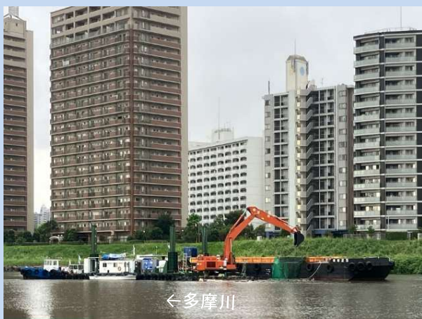
河道内を掘削しています。 (令和6年8月)
