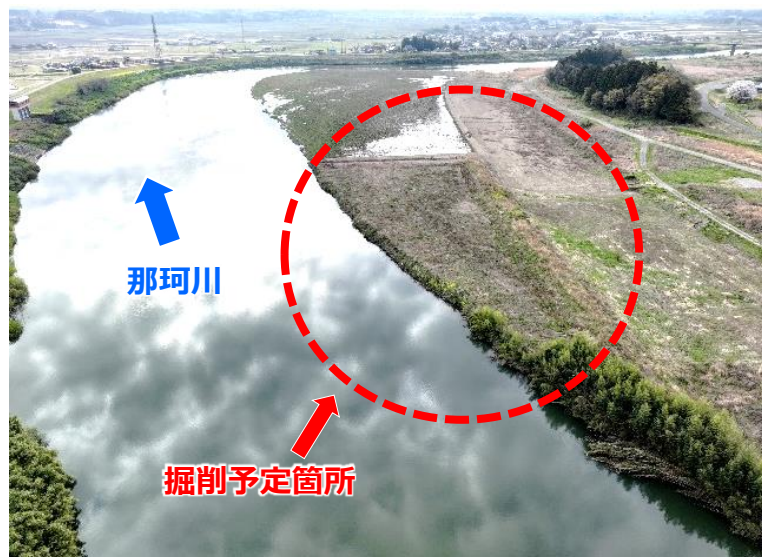
河道掘削予定箇所（水戸市渡里町）
