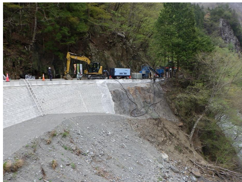
【モルタル吹付工 施工状況】
