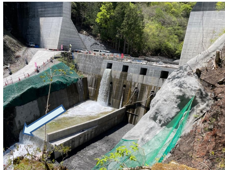
左岸下流側より望む
