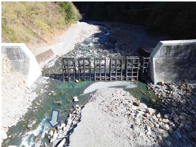
【下流側上空より砂防堰堤施工箇所を望む】
