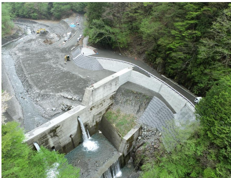
【下流側上空より施工箇所を望む】
