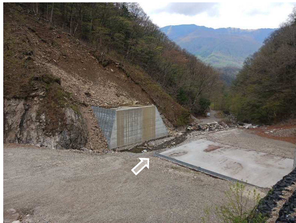
上流 右岸より本堰堤を望む（コンクリート堰堤工） （未着手）
