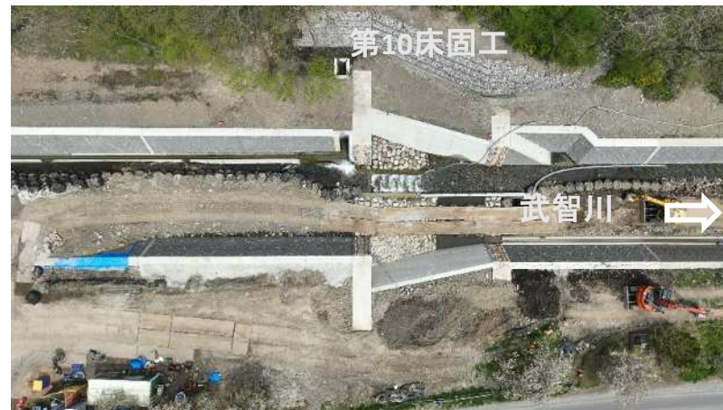
↑ 上空より施工箇所（第10床固工と護岸 ブロック積）を望む
