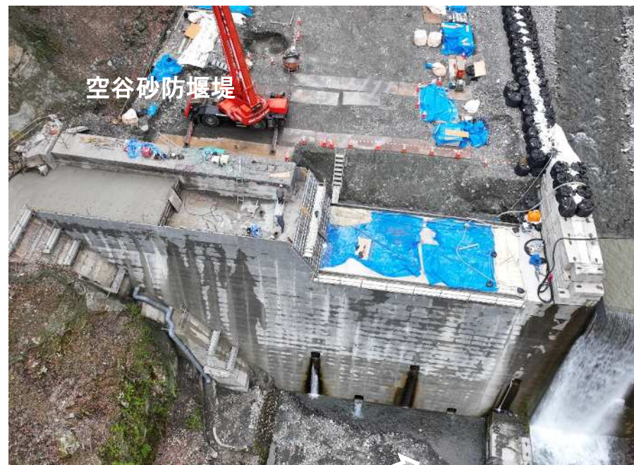
コンクリート堰堤（腹付け） 施工状況
