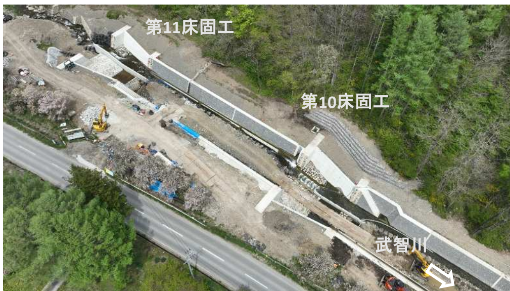
右岸上空より施工箇所を望む
