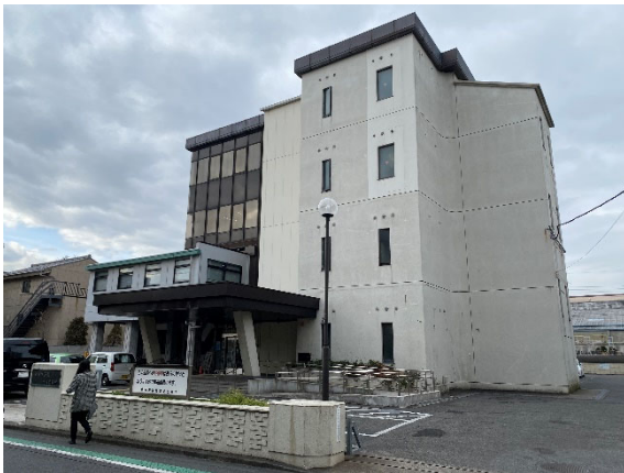
① 庁舎外観
