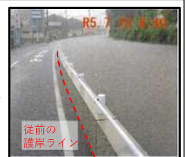
<池町川護岸嵩上げ>
