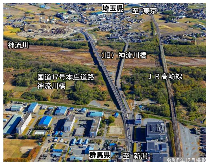
神流川橋付近の状況
