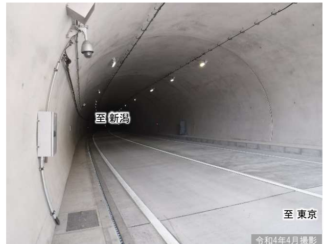
②新三国トンネル内部の状況
