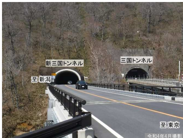
①新三国トンネルの状況
