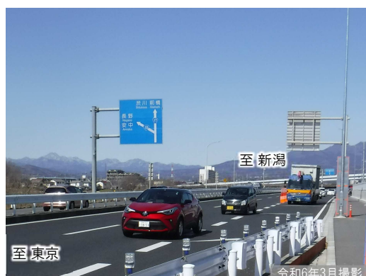
①国道17号・18号合流部（拡幅区間）
