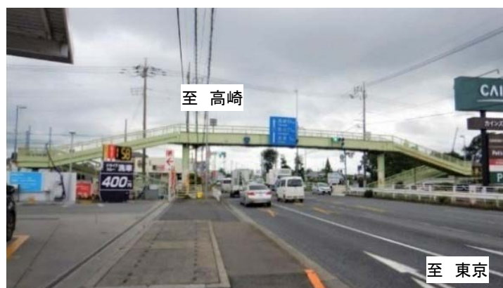
【橋梁全景(下り線より終点を望む)】
