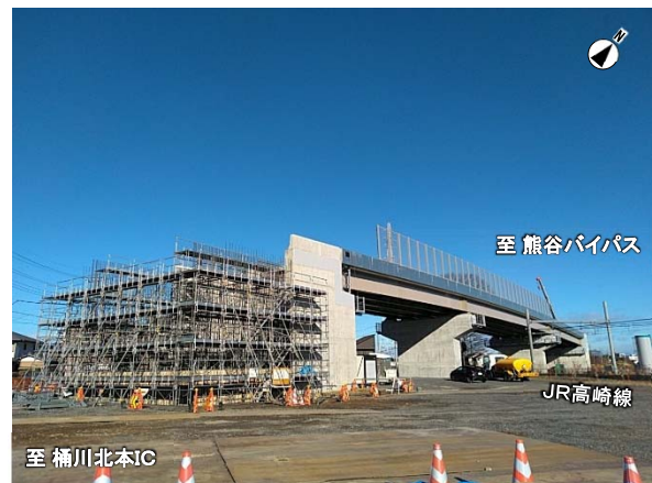
【箕田地区の施工状況】
