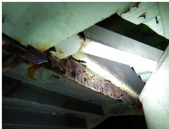
・地覆の腐食 <地覆補修>
