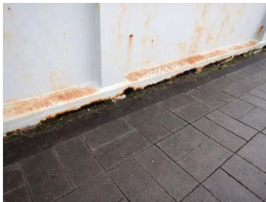
・地覆の腐食 <地覆補修>
