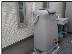
貯留槽の整備事例（富士市）
