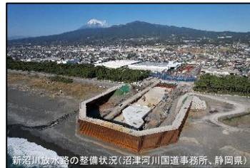
新沼放水路の整備状況（沼津河川国道事務所、静岡県）
