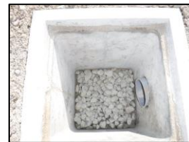
雨水貯留浸透枡整備事例（昭和町）
