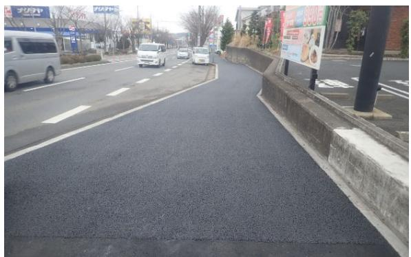
雨水を浸透させる透水性舗装を実施
