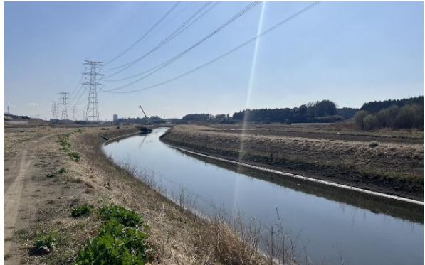
洪水を安全に流すために河道掘削を実施。
