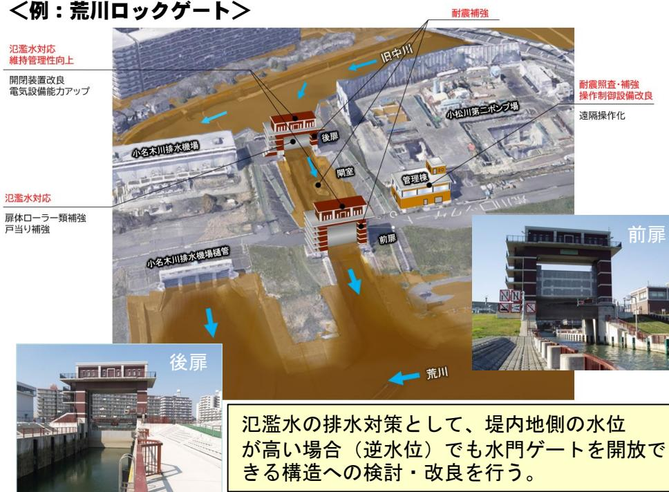
氾濫水の排水対策として、堤内地側の水位が高い場合（逆水位）でも水門ゲートを開放できる構造への検討・改良を行う。
