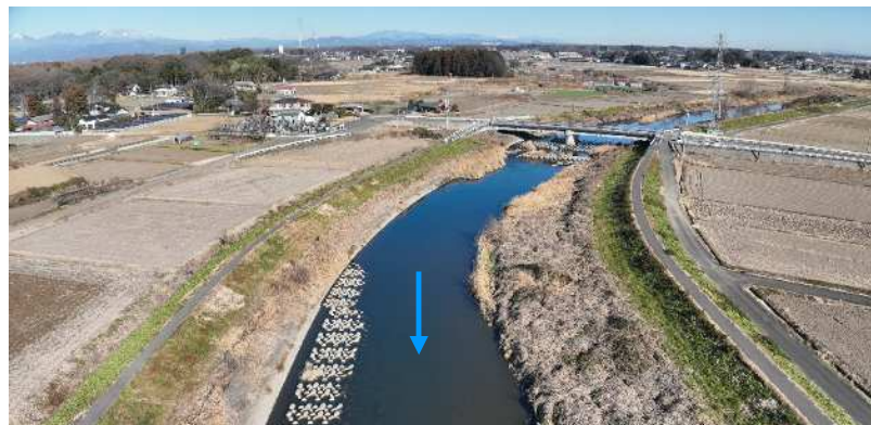
UAVを活用した目視点検
