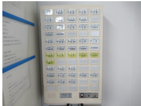
図2 事務庁舎棟（副受信機）
