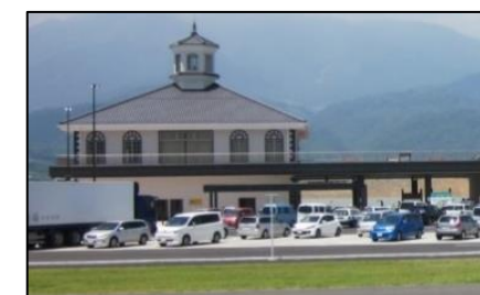
道の駅富士川(外観)
