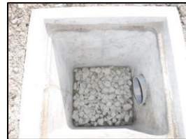
雨水貯留浸透枡整備事例（昭和町）
