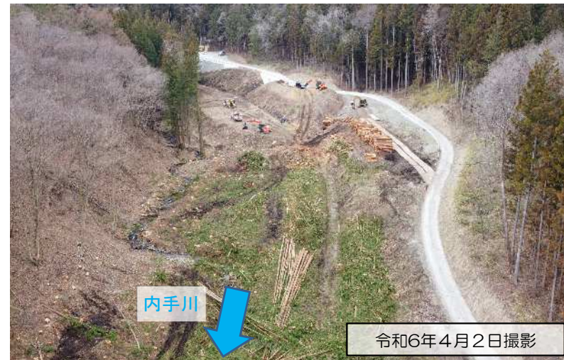
下流側上空から
