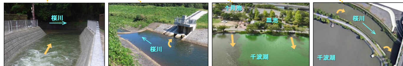
那珂樋管から取水した那珂川河川水を、桜機場で桜川に放流します。 その水を桜川取水堰から取水し、月池を経由して千波湖に流れ込みます。
