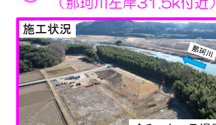
施工状況 令和6年2月撮影
