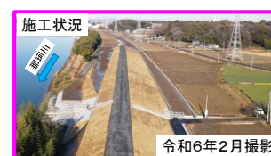
施工状況 令和6年2月撮影
