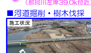
施工状況 令和6年2月撮影
