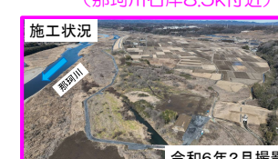
施工状況 令和6年2月撮影
