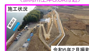
施工状況 令和6年2月撮影
