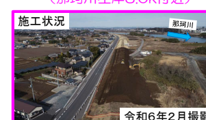
施工状況 令和6年2月撮影
