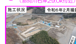
施工状況 令和6年2月撮影
