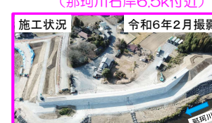
施工状況 令和6年2月撮影
