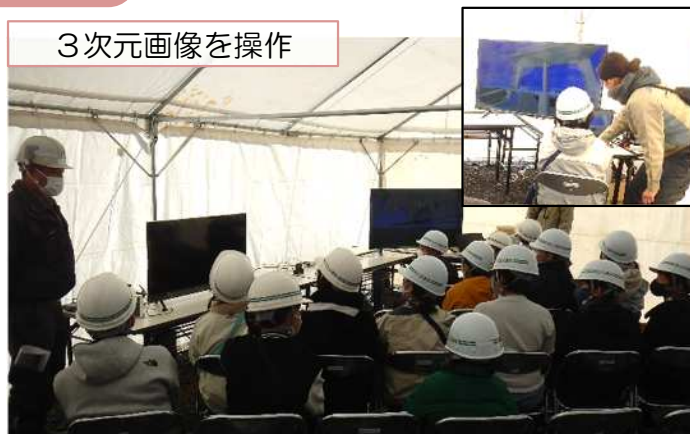
排水門の3次元画像を画面上で操作
