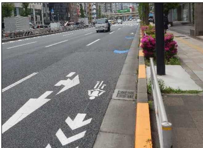
国道15号 浜松二丁目交差点 付近 (R4整備)
