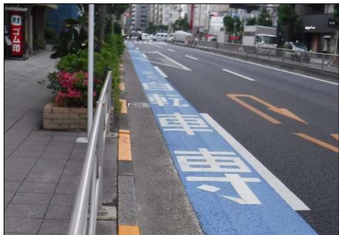
国道6号 小伝馬町交差点 付近 (R3整備)
