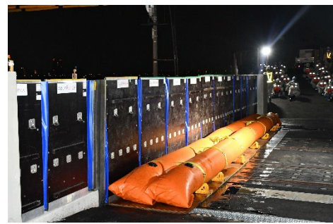
大型水のう設置
