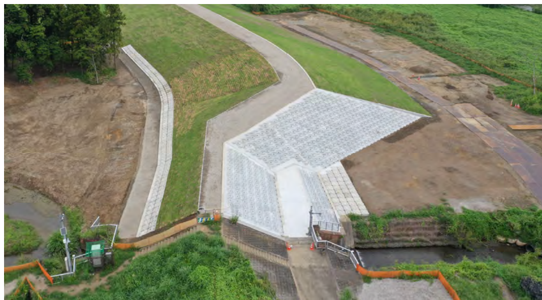
小剣樋管(R2.11撮影) (内空 幅1.8m 高さ1.4m (×1連))
