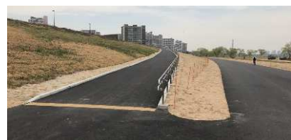
整備されたアクセススロープ
