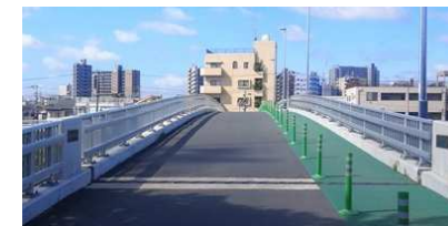
整備された新志茂橋
